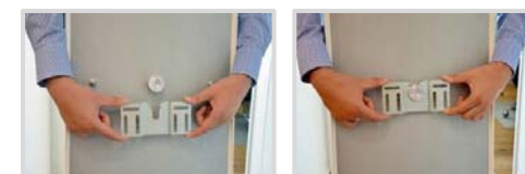
Montage/Befestigung der Infrartheizung an Wand oder Decke.
